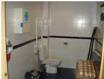
➤ El inodoro está situado a una altura de 41 cm y el mecanismo de descarga a 76,5 cm. Tiene un espacio libre de aproximación frontal de 95 cm de ancho y por el lado derecho de >1,50 m de ancho.
