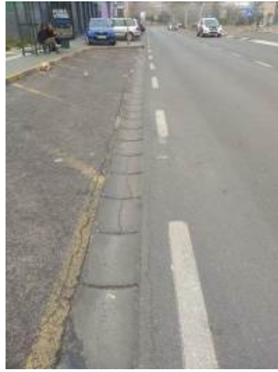
Foto 16. Canaleta de hormigón.
