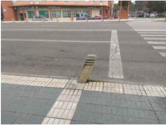
Foto 5. Fisura transversal.
