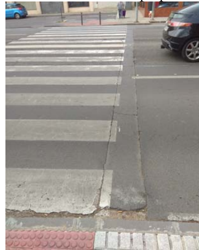
Foto 8. Cruce de zanja
