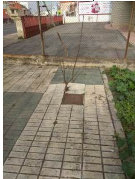
Foto 31. Baldosas levantadas
