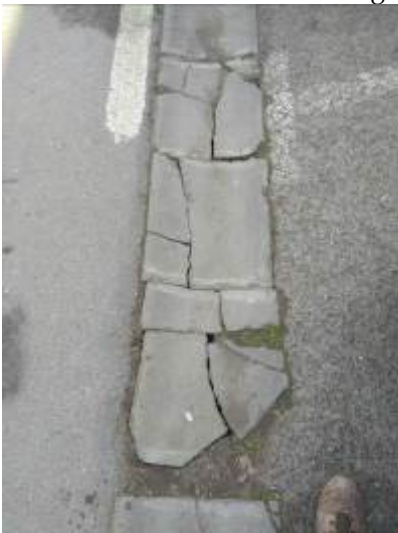
Foto 17. Canaleta de hormigón
