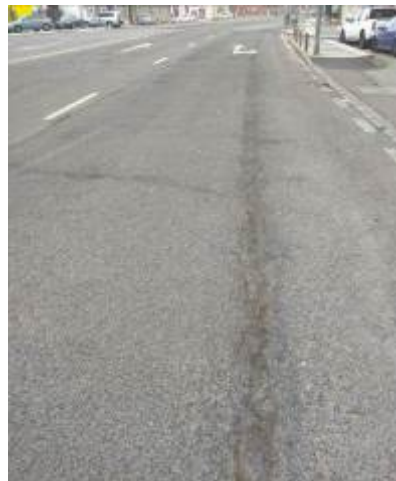
Foto 4. Fisuras longitudinales.
