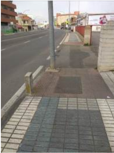
Foto 24. Discontinuidad en acerado.
