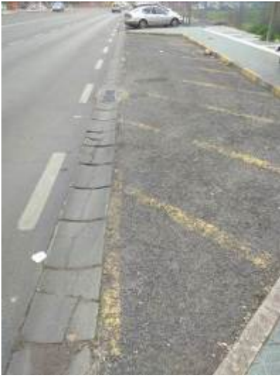
Foto 15 Canaleta de hormigón.
