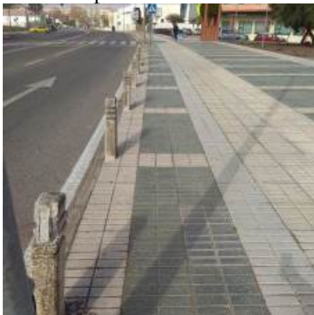
Foto 41a.: Bolardos de hormigón.
