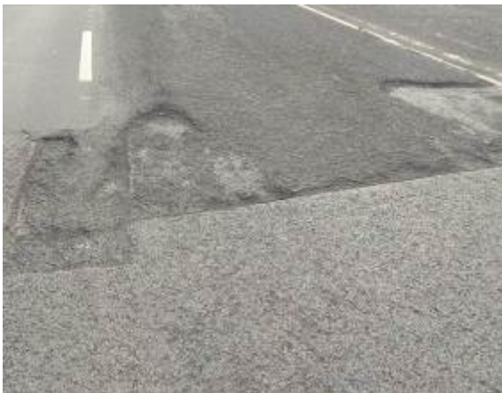
Foto 13. Asfalto disgregado.
