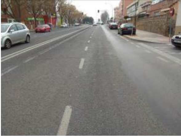
Foto 11. Conexión entre asfaltos.
