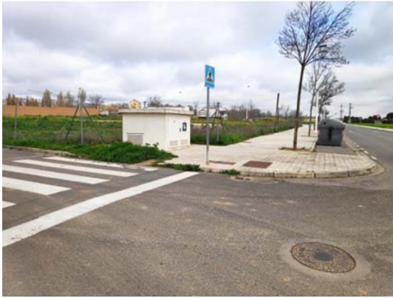
Foto 7: Ausencia de oreja al inicio de la calle
