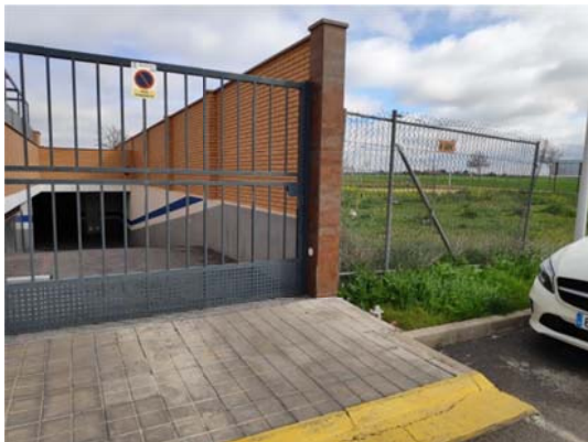
Foto 3: Acerado existente en fachada del bloque
