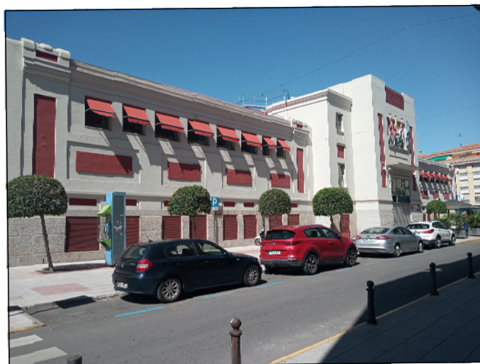
Vista fachada principal. C/ Postas
