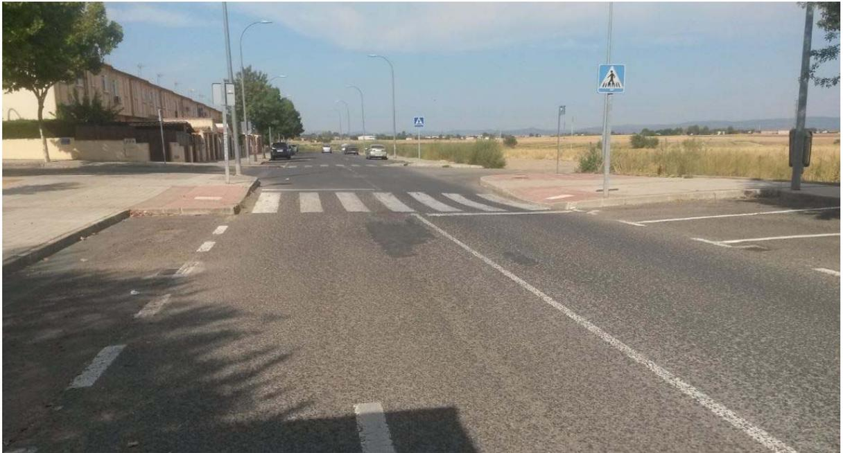
Vista general del hundimiento del paso. Se observa con claridad como las franjas blancas del paso de peatones están torcidas, reflejando el hundimiento de la calzada.
