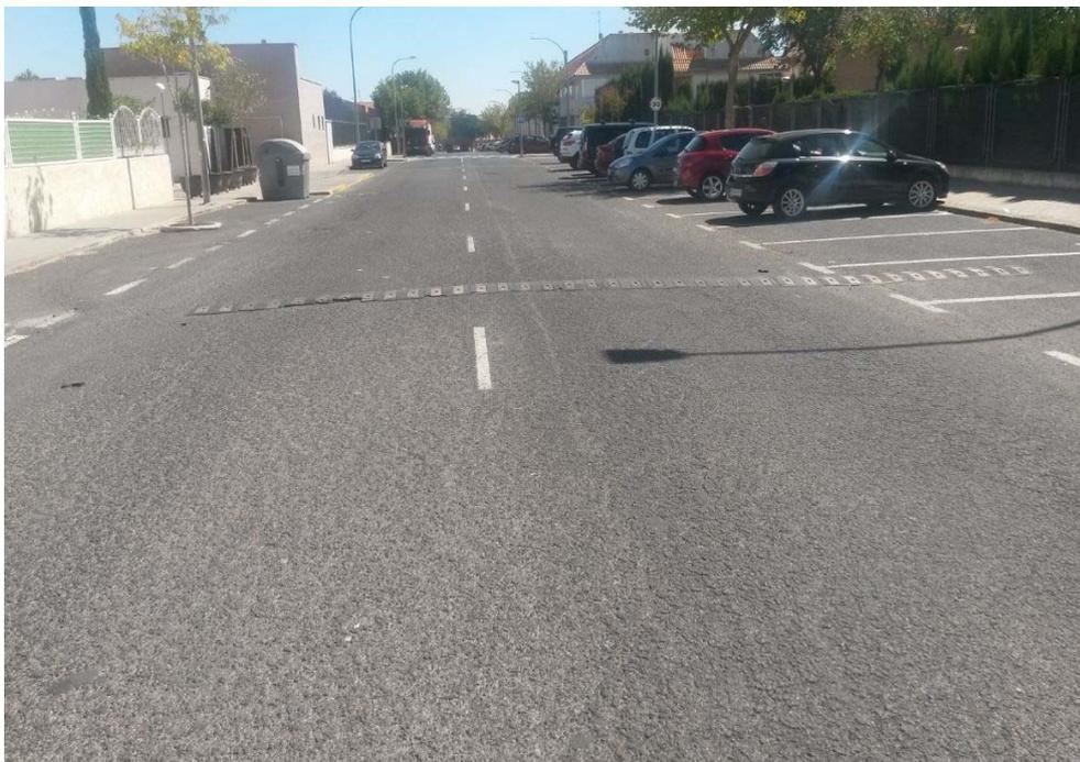
Aspecto general de la calzada deteriorada. La capa de rodadura está muy abierta
