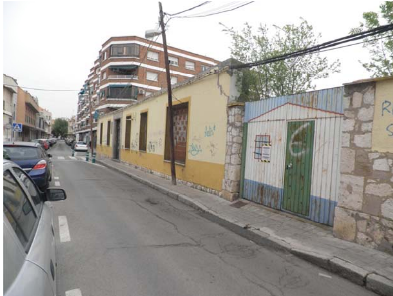
1 Cerramiento actual calle Lirio
