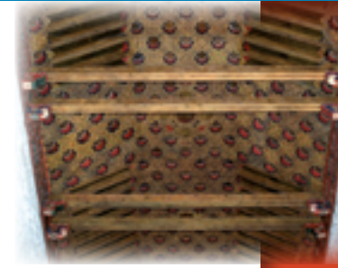
Armadura de la Iglesia de Santiago
